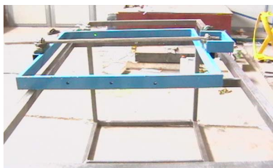
شکل ۵: نصب توربین بر روی اسکلت
